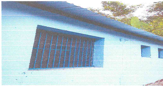
Foto1: Así quedo paredes remozadas y ventanales
