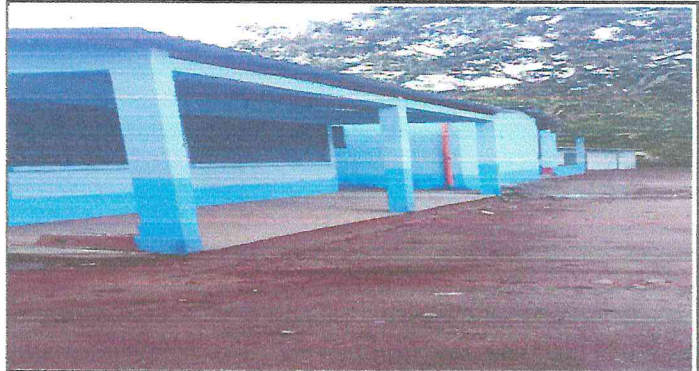
Foto 4: Así quedo el repello y pintura de paredes
