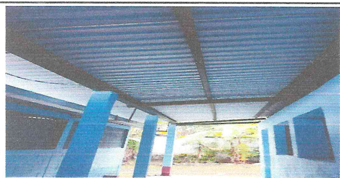
Foto 5: Vista de techo de aulas
